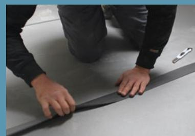
Assurer l'étanchéité avec la bande StickelFoam 25/70 fournie
